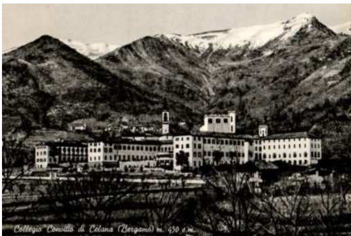
Caprino Bergamasco, frazione di Celana, Collegio Convitto
